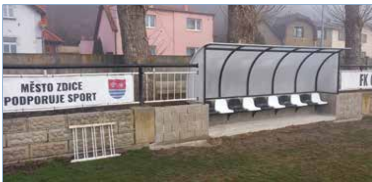
» Instalace nových střídaček na fotbalovém hřišti zdické Olympie.
