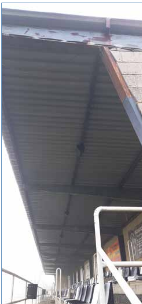
» Tribuna na fotbalovém hřišti projde v létě renovací pláště a střešní konstrukce.
