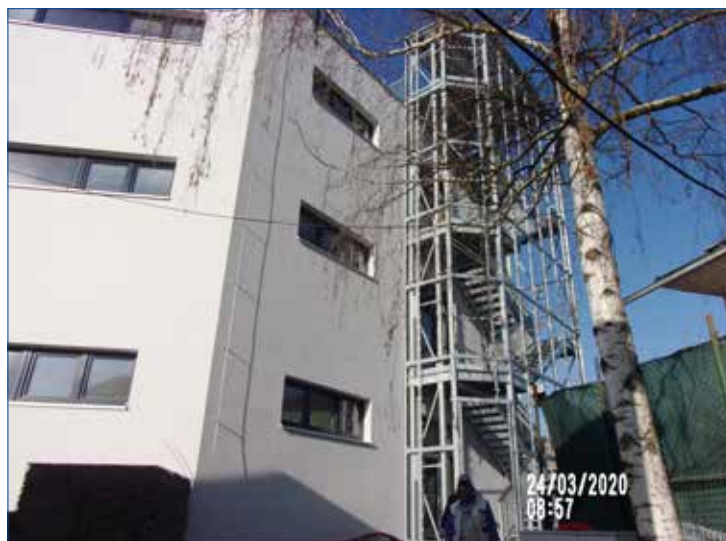
» Na budově ZŠ je namontováno nouzové schodiště, které bylo prodlouženo z důvodů budování střešní přírodní učebny na střeše budovy.
