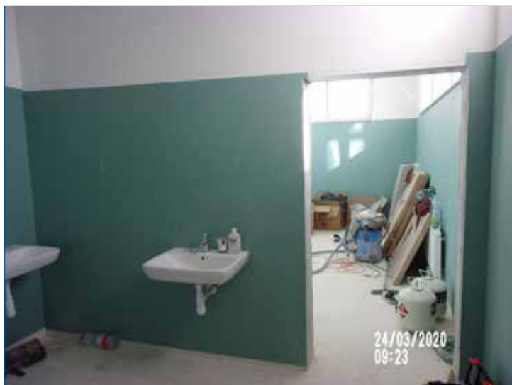
» Pohled do rozdělaných prostor sociálního zařízení.
