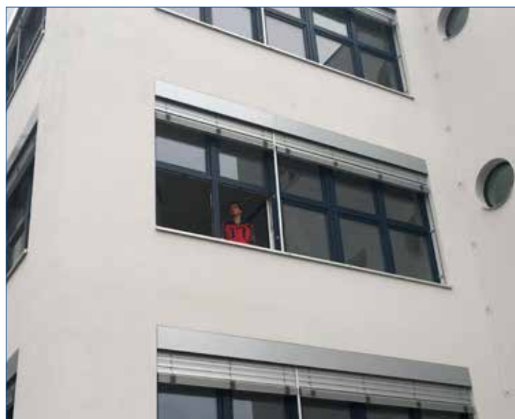
» Montáž oken, kování a rolet na novém pavilonu zdické základní školy.
