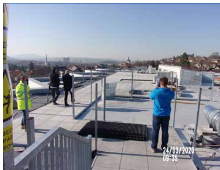
» Střecha budovy, kde je ještě rozpracována střešní-přírodní učebna pro žáky ZŠ. Mimo vyučování bude možné využívat i pro školní družinu. Součástí bude i plocha na protahovací cvičení.
