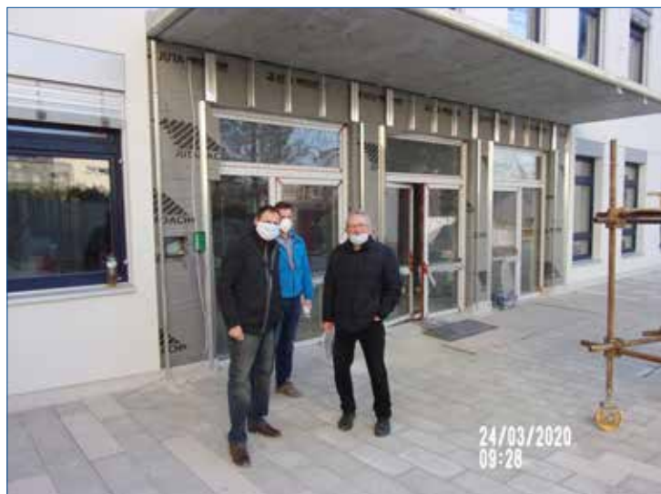
» Snímek zachycuje na kontrolním dnu stavby místostarostu Richarda Dolejše, hlavního projektanta Ing. arch. Tomáše Šantavého společně s jedním stavbyvedoucím Ing. Martinem Buřičem.
