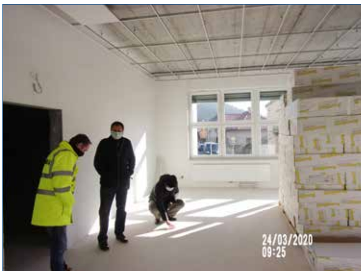
» Kontrola kvality provedené stěrky na podlahách s vedoucím stavby firmy Subtera Ing. Tomášem Hadáčkem.
