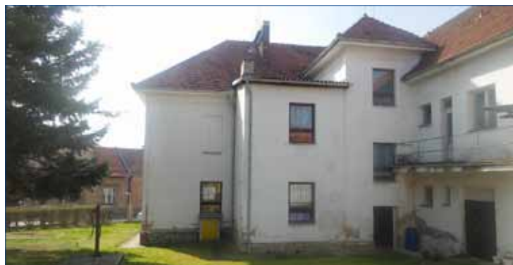
» Budova staré mateřské školy v ulici Žižkova.
