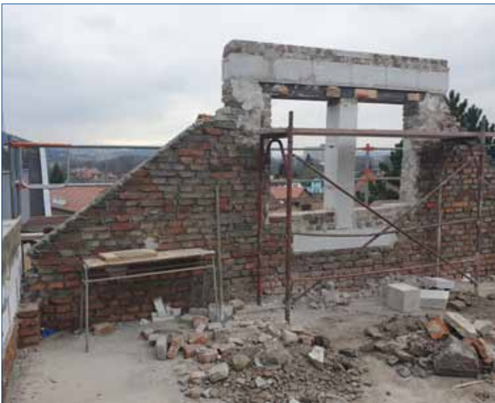
» Z budovy zůstaly pouze obvodové zdi a byla zvýšena. Poslední strop byl zesílen a v uvedených prostorech bude umístěn archiv městského úřadu.
