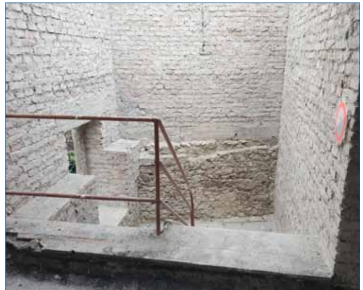
» Z budovy zůstaly pouze obvodové zdi a byla zvýšena. Poslední strop byl zesílen a v uvedených prostorech bude umístěn archiv městského úřadu.
