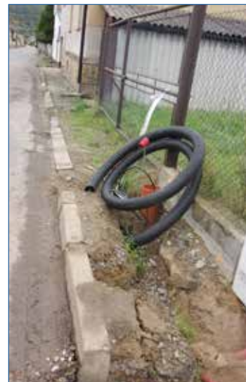
» Pokládka kabelů pro osvětlení.
