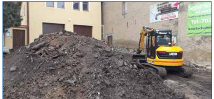
» Velký přesun materiálu byl zejména před budovou městské policie, kde bylo potřeba vyřešit problémy s dešťovou kanalizací.
