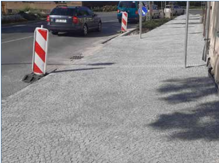
» Dokončená dlažba, která ukončuje historický okruh centra města vztahující se k pěší zóně, kde sídlí historicky chráněné budovy radnice, fary a kostela.
