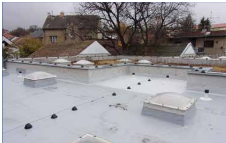
» Finální podoba opravené střechy Společenského domu Zdice.
