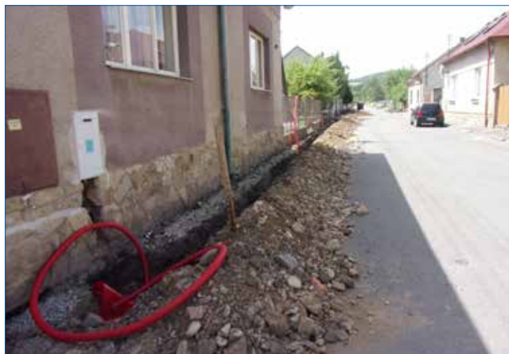
» Výkopy pro pokládku kabelů pod zámkovou dlažbu.
