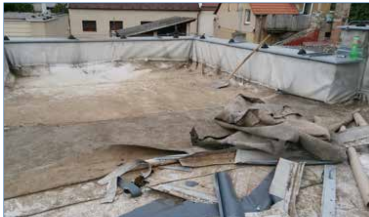
» Kačírek byl ze střechy odstraněn.
