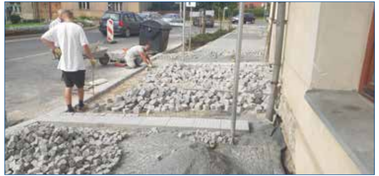
» Pohled na pracovníky při realizaci dlažby.
