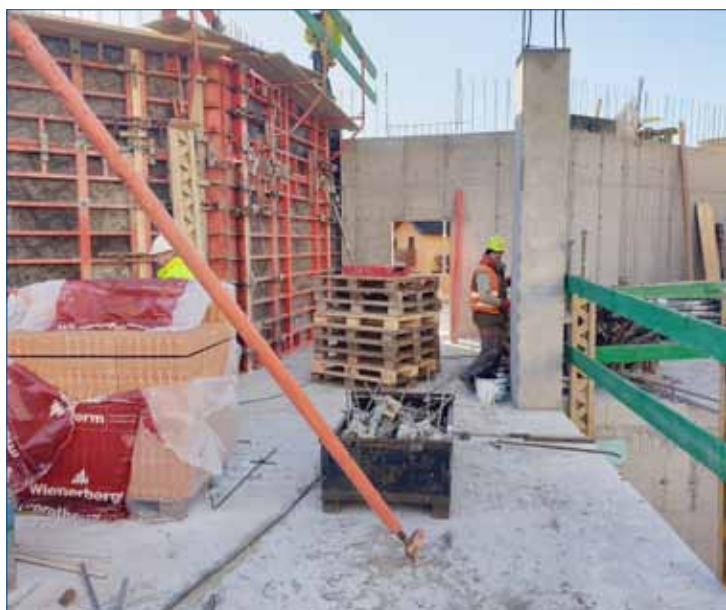
► Z kontrolního dne na stavbě nového pavilonu základní školy ze dne 5. března 2019.
