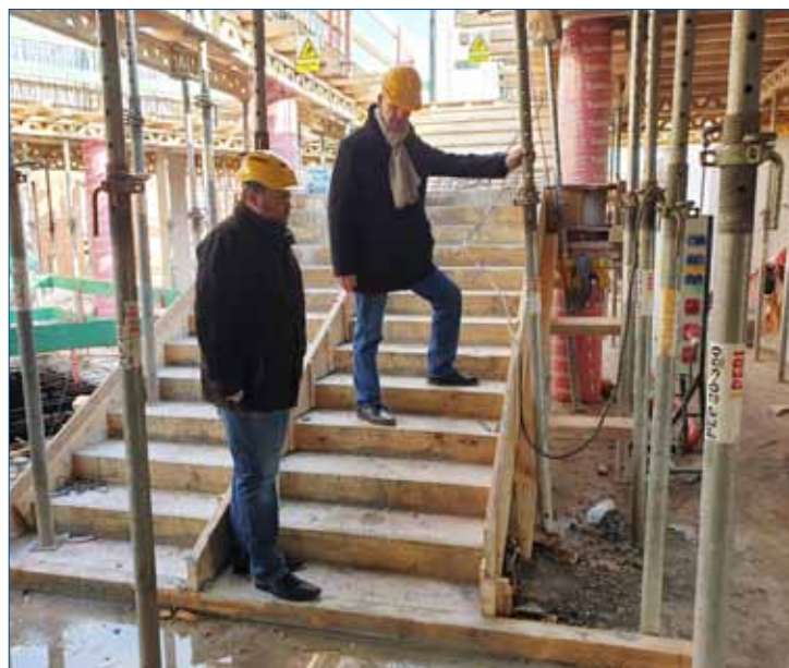
► Kontrolní dny přímo na stavbě jsou každé úterý. Součástí schodiště do horních pater bude ještě finální povrchová úprava. Tyto schody jsou podle projektové dokumentace přímo na stavbě šalované a vybetonované. Jiná technologie schodů je použita do suterénu budovy, kde budou především šatny. Byly vyrobeny a povrchově již finálně ošetřeny a na místo pouze dopraveny jeřábem. Budou nejvíc zatíženy. Na fotografii ze dne 19. 3. 2019 při kontrolním dnu starosta města Bc. Antonín Sklenář s místostarostou Mgr. Přemyslem Landou.
