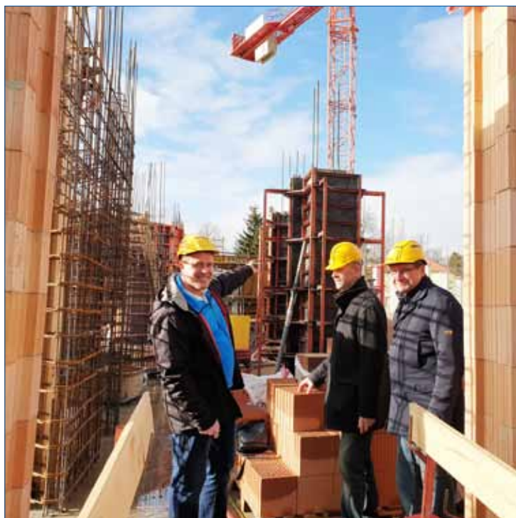
► Představitelé města Zdice Bc. Antonín Sklenář - starosta města, Richard Dolejš - místostarosta města Zdice za asistence stavbyvedoucího Ing. Martina Buřče z firmy Auböck s. r. o. při jednom z kontrolních dnů stavby nového pavilonu školy.
