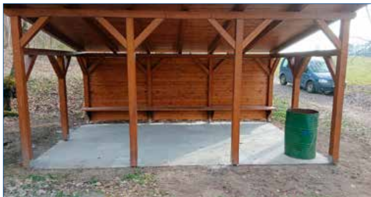
» Nová betonová podlaha pod přístřeškem na Kapce v Knížkovících.
