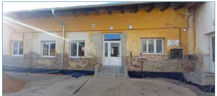
» Oprava fasády včetně výměny oken a odvodnění svodů dešťové vody na budově, která bude sloužit pro zázemí SaTZM v areálu bývalých kasáren.
