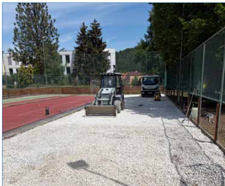
» Oprava víceúčelového hřiště u ZŠ
