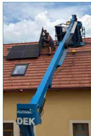
» Realizace fotovoltaiky na budově městské policie.
