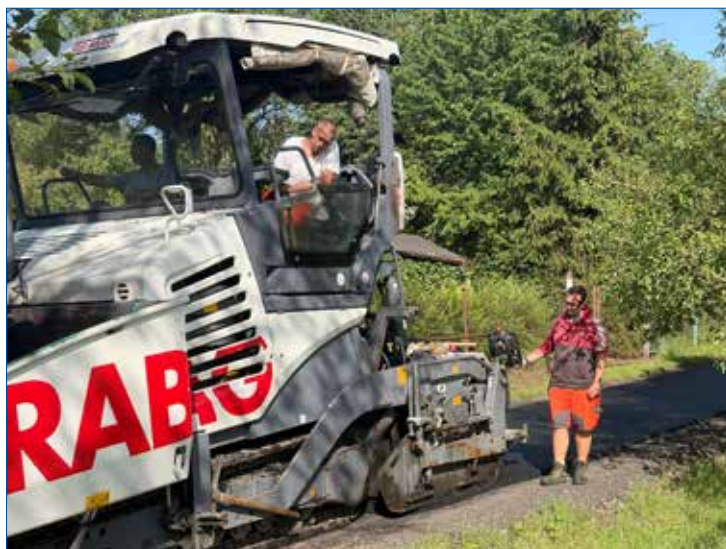
» Rekonstrukce Hroudské ulice. Pokládka nového asfaltu.
