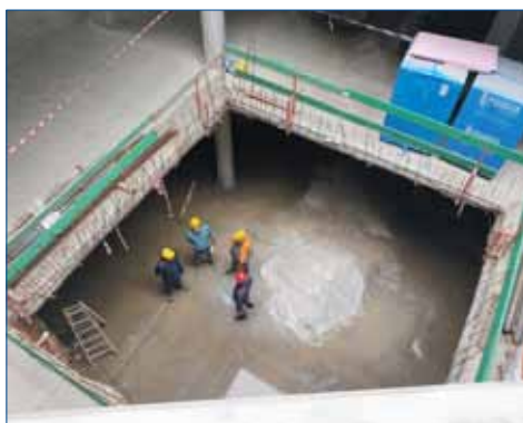
» Díra, která na stavbě zbyla po stavebním jeřábu, který se demontoval 12. 7. 2019.
