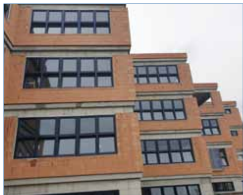
» Okna instalovaná na ZŠ, jsou z venku tmavě modré.
