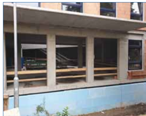
» Snímek zachycuje hlavní vchod do nové školní budovy.
