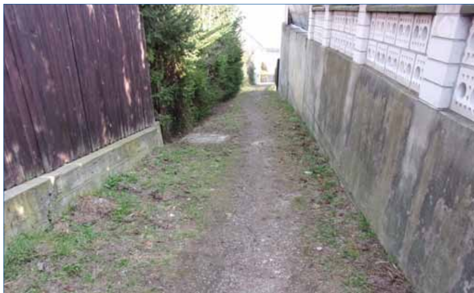
» Původní povrch uličky směrem k ulici Na Vyhlídce.
