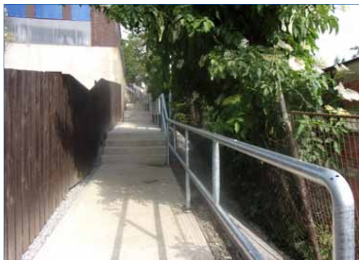
» Pohled na horní část již vybudované uličky i s instalovaným zábradlím. Uvedený stavební stav, by měl pomoci rodinným domům pod uličkou se zachycením dešťové vody.
