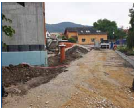
» Součástí projektu je i položení nové dlažby před oběma budovami základní školy.
