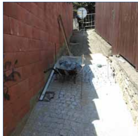
» Pokládka dlažebních kostek v horní části uličky, kde bylo nutné začít úpravou sklonu povrchu do spodního kanálu pro odtok dešťové kanalizace.
