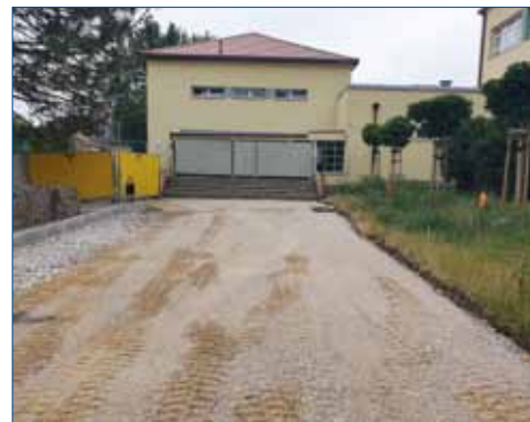
» Nového vstupu se dočkají i žáci na I. stupni základní školy.
