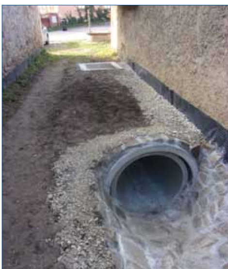
» Pohled k návsí na již opravený úsek, který vodu směřuje do dešťové kanalizace.
