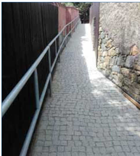
» Snímek zachycuje horní část uličky i s instalací zábradlí.
