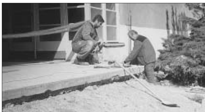
Rekonstrukce schodů u vchodu do budovy ZŠ v Žižkově ulici provedla v květnu firma HASSTAV z Králova Dvora.
