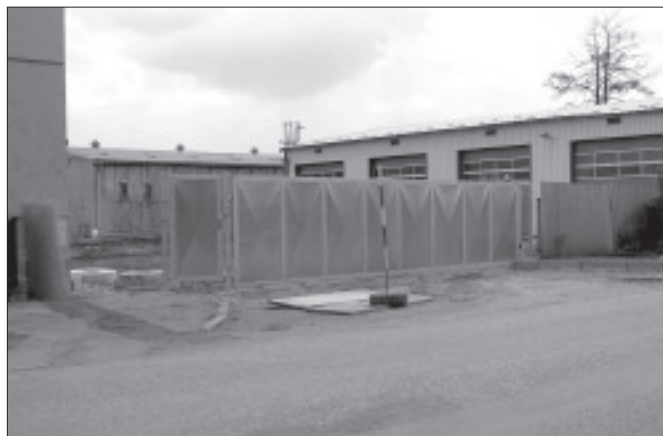
Do zrekonstruované hasičské zbrojnice v bývalých kasárnách byl vybudován nový samostatný vjezd. Foto: Sm.
