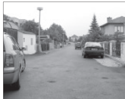
Celkový pohled na opravenou komunikaci v ulici Na Vyhliďce. 2x foto: Sm.
