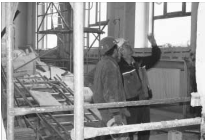
Na rekonstrukci společenského domu se pilně pracuje. Pohled do hlavního sálu. Foto: Sm.
