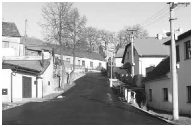
V rámci rekonstrukce komunikací získalo v závěru roku 2006 pěkný vzhled Zdíkovo náměstí a ulice vedoucí ke hřbitovu. Foto: Sm
