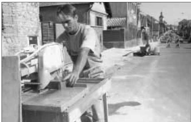
Firma Strabag provedla v srpnu rekonstrukci chodníku v Komenského ulici. Na snímku z posledních srpnových dnů pracovník firmy při řezání dílů zámkové dlažby.
