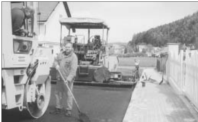
V Poncarově ulici vybudovali pracovníci firmy Strabag nový chodník a s pomocí těžké techniky položili asfaltový povrch vozovky. Foto: - sm -
