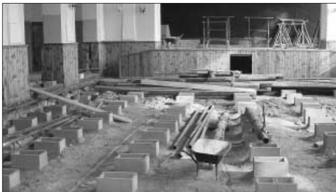
Veliká rekonstrukce společenského domu probíhá podle plánu. Pohled do hlavního sálu, kde se buduje nová podlaha.
