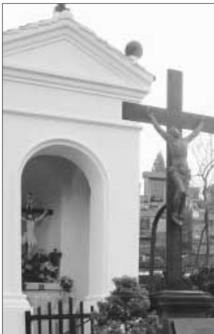
Opravu kapličky na hřbitově provedla firma pana Špačka ještě před Dušičkami. Návštěvníci hřbitova opravu hodnotili kladně.
