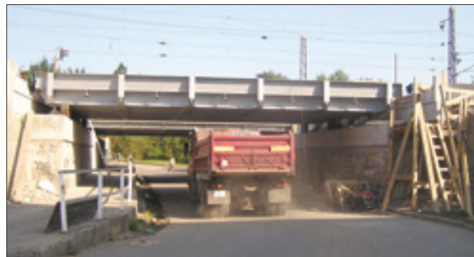
V důsledku prováděné rekonstrukce železničního mostu v ulici Čs. armády bylo nutné uzavřít průjezd silničních vozidel. Projíždět mohla pouze auta stavebních firem.
