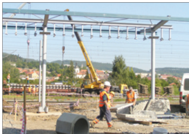
Optimalizace trati Beroun – Zdice probíhá podle harmonogramu. Stavební práce na zdickém nádraží jsou v plném tempu.
