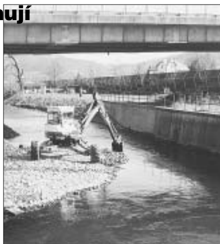
Na čištění koryta Červeného potoka a Litavky pracovala firma Lesostavby Beroun. Na snímku jsme zachytili pracovníka firmy právě v blízkosti dálničního mostu. Foto: - sm -
